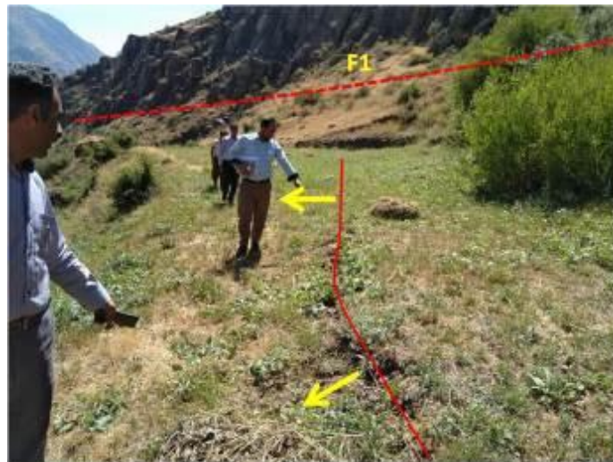
شکل ۱۲: آثار ترک‌های کششی روی زمین در منطقه شماره ۲ شکل ۷-۵، امتداد خط گسیختگی منطق بر زمین لغزش قدیمی و جهت حرکت به سمت درون توده لغزشی است و نشان دهنده شکل‌گیری اسکارپ اصلی زمین لغزش است.
