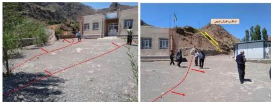
شکل ۱۷: آثار حرکت زمین لغزش در منطقه ۶ در شکل ۱۱.
