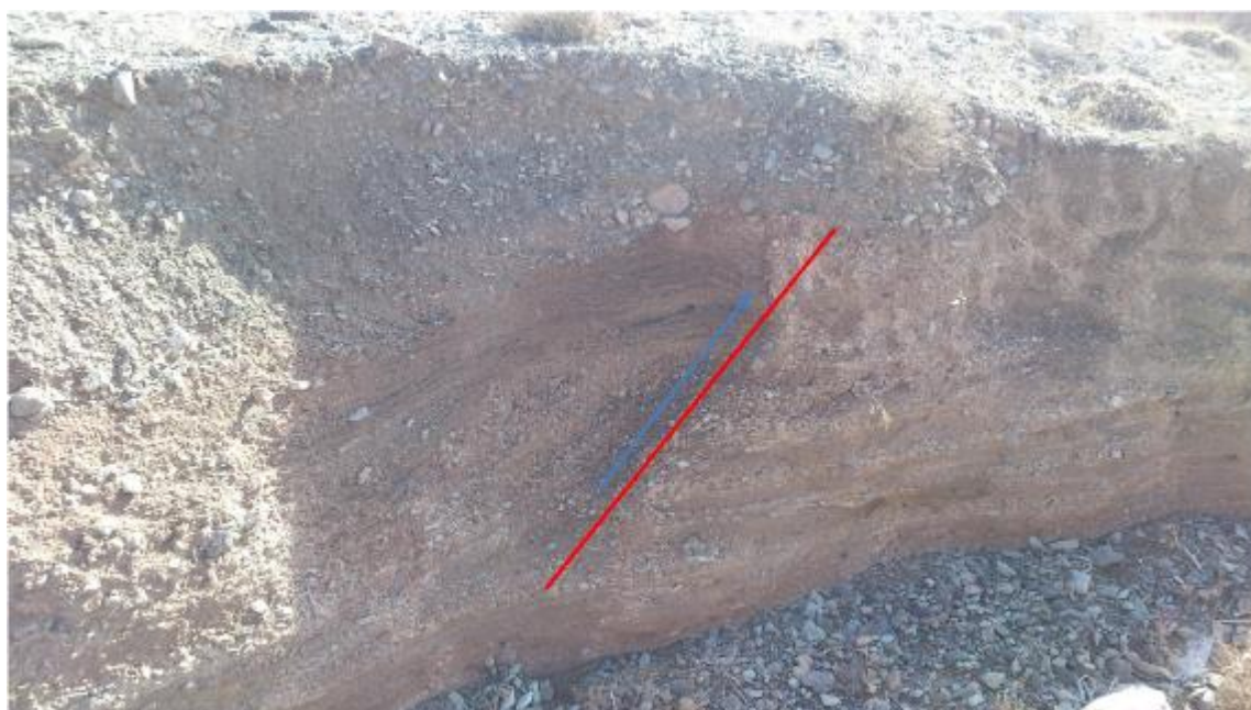
شکل شماره ۱۸: نمایی از گسل کوندج در جنوب روستای فالیزان در مختصات 50/20/38.5 ، 36/09/27.2 (دید به سمت شرق). در این مقطع رسوبات ریزدانه رسی توسط گسل جابجا شده اند و پس از جابجایی این لایه، لایه شنی جوان تر بر روی آن نهشته شده است. این تصویر نمای روبروی تصویر شکل شماره ۱۷ هست که در دیواره شرقی آبراهه جنوب روستای فالیزان دیده می شود.
