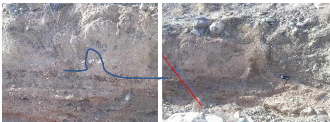
شکل شماره ۱۵: نمایی از گسل کوندج در جنوب روستای فالیزان در مختصات 50/20/38.2 , 36/09/39.4 (دید به سمت غرب). در این محل لایه بندی متناوبی از ریزدانه رسی - سیلتی و لایه واجد دانه های درشت تر توسط گسل جابجا شده است.
