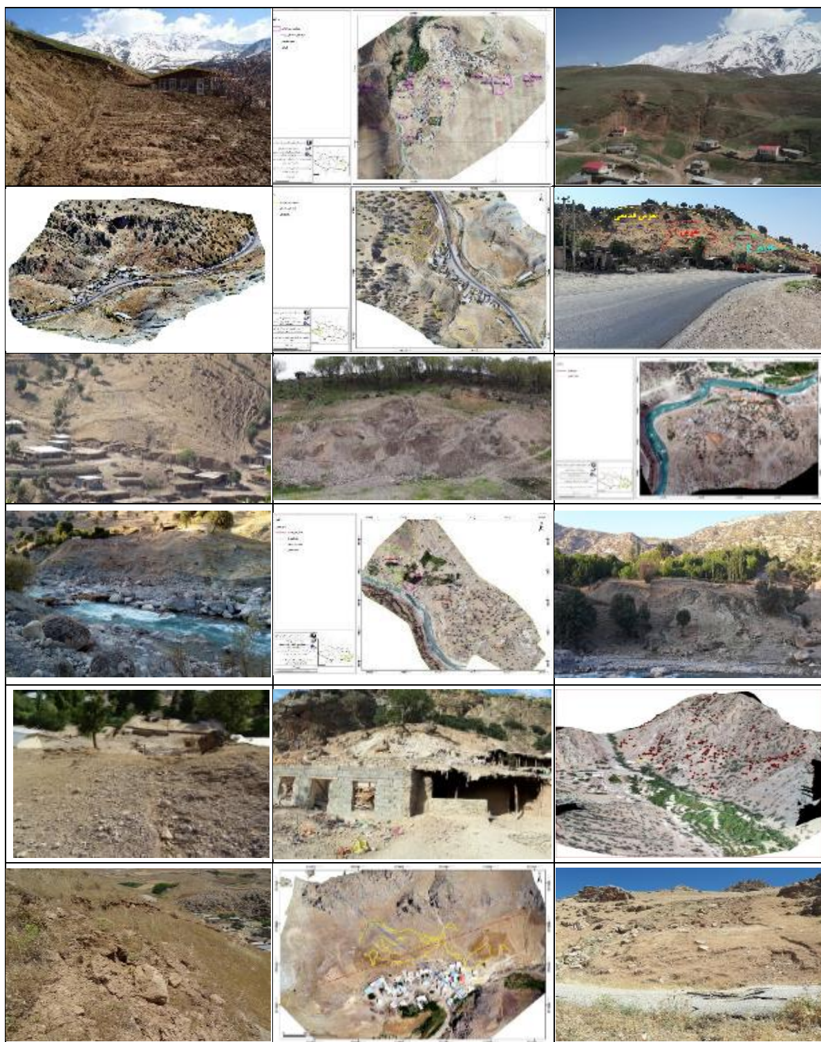
شکل شماره ۸: ردیف ۱: زمین لغزش قلعه رستم، ردیف ۲: زمین لغزش گنجعلی پایین، ردیف ۳: زمین لغزش چال پره، ردیف ۴: زمین لغزش کیش گله بید، ردیف ۵: زمین لغزش موباه و ردیف ۶: زمین لغزش گرماوله علیا، برگرفته از گزارش پایدارسازی زمین لغزش ها و گزارش بازدید اولیه روستاها
