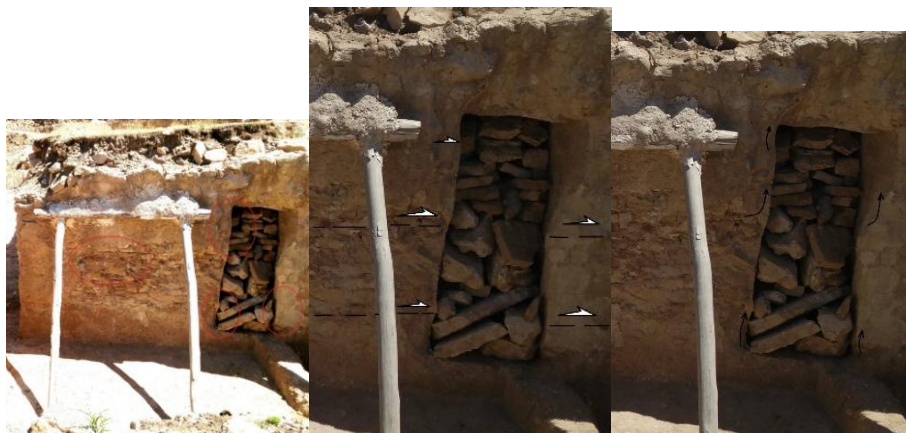
شکل ۲۹. انحراف و مسیر اعمال انرژی حرکتی در خطوط مستقیم دیواره و چهارچوب در
