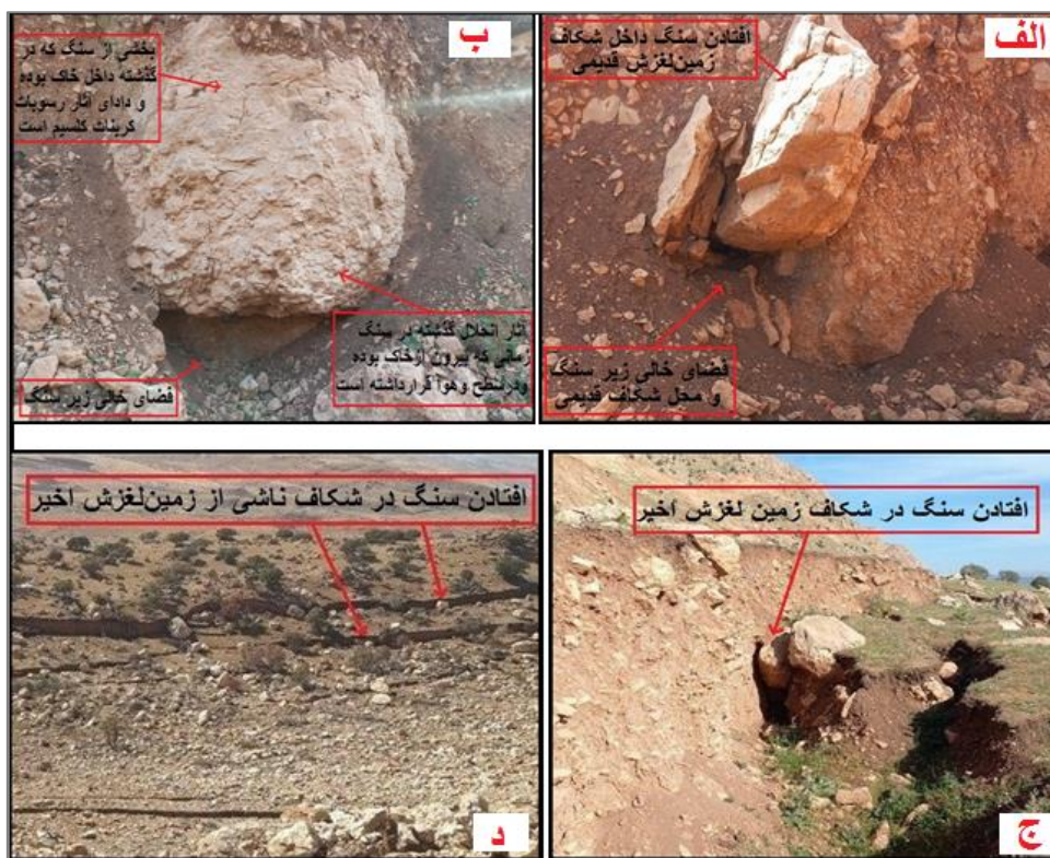
شکل ۱۳: افتادن سنگ داخل شکاف در اثر زمین لغزش و نمونه آن در زمین لغزش اخیر (مأخذ: نویسندگان). (تصویرالف نقطه u در شکل ۱)، (تصویر ب نقطه v در شکل ۱)، (تصویر ج نقطه w در شکل ۱)، (تصویر د نقطه z در شکل ۱).
