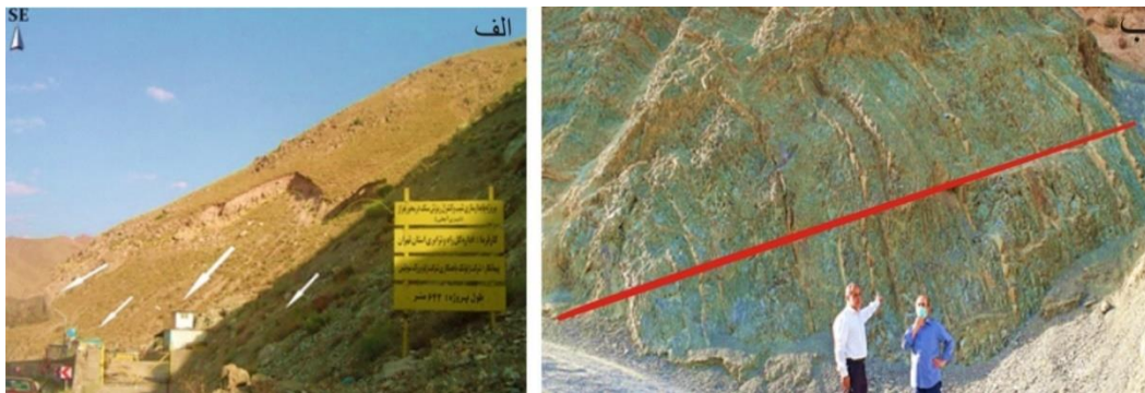
شکل ۲- الف) نمایی از ناپایداری شیب ها در مسیر جاده اُبعلی به امامزاده هاشم و تدابیر انجام شده به منظور جلوگیری از زمین لغزش ها و ریزش سنگ های احتمالی ب) نمایی از رخنمون شاخه هایی از گسل اصلی شمال تهران با همراه با چین خوردگی (دید به سمت جنوب خاور).
