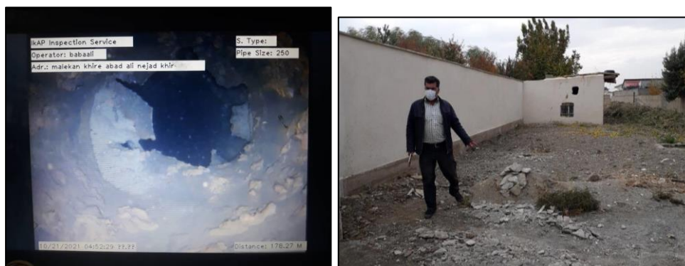
شکل ۷: شواهد فرونشست در جنوب دشت هشتگرد، روستای خیرآباد و بریده شدن لوله جدار در عمق ۱۷۰ متر
