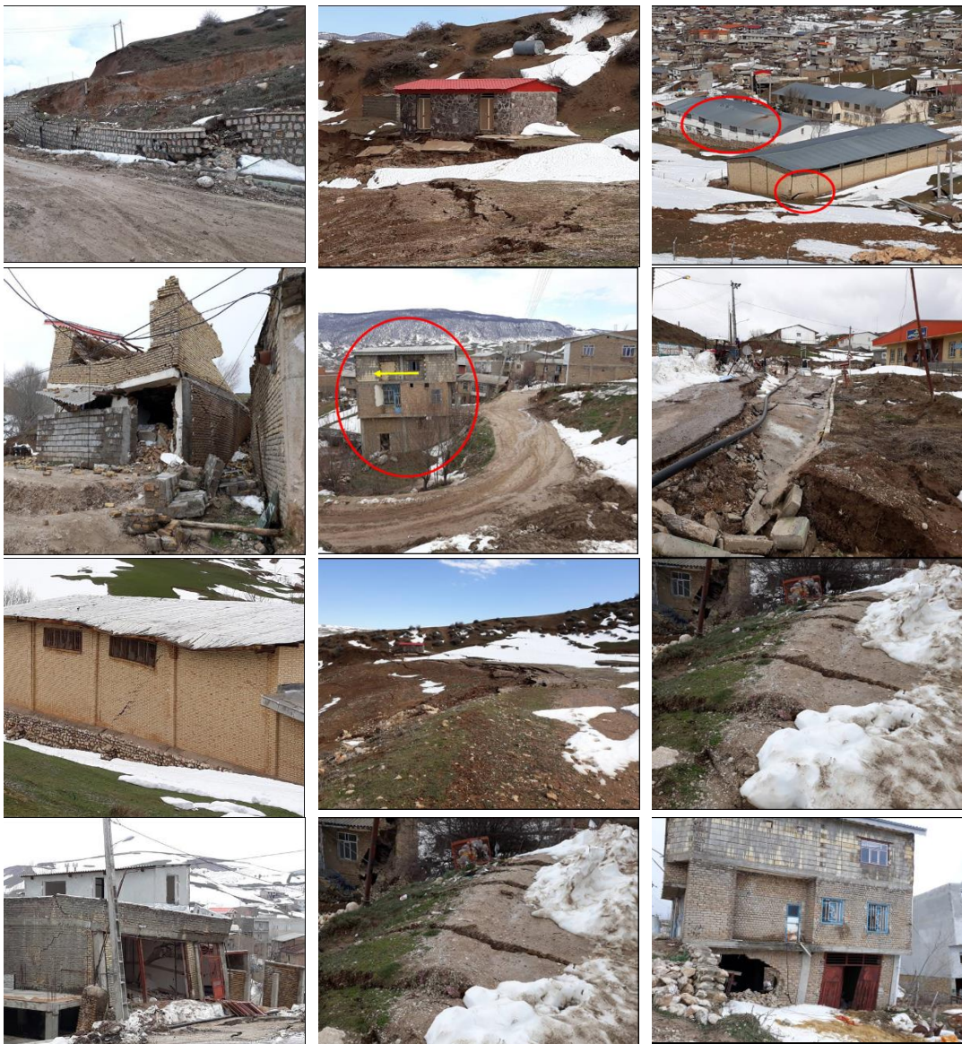
شکل شماره ۵: تصاویر آثار تخریبی زمین لغزش پایین دست سد کالپوش، برگرفته از گزارش پایداریسازی زمین لغزش و گزارش بازدید اولیه روستا
