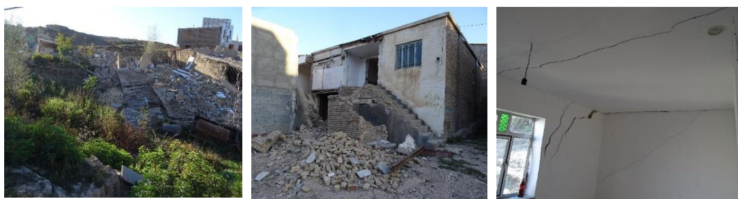
شکل شماره ۱۱: تصاویری از خسارات ناشی از زمین لغزش‌های روی داده در دامنه‌های محله سعادت‌آباد، برگرفته از گزارش پایدارسازی زمین لغزش روستا
